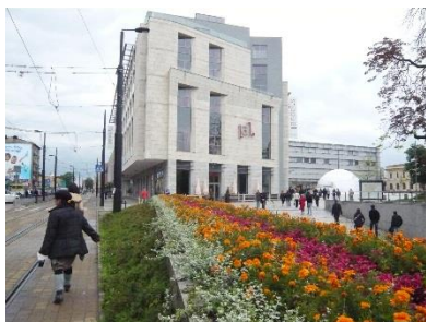
ホテルの概観。左手の線路は市電、右手奥に中央駅がある。
